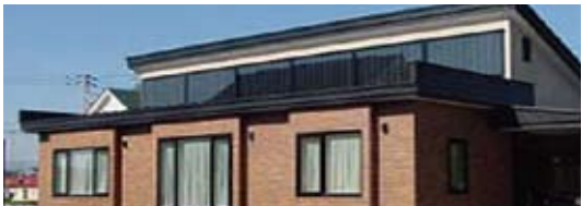
ウッドイハウス（北海道・芽室）二階南面壁に設置
