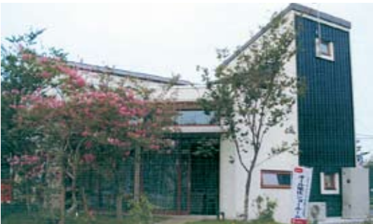
東京電力「スイッチステーション浦安」 東京電力オール電化ハウス（千葉県浦安住宅公園内・2006 年 4 月オープン）にソーラーこはるびが採用されています。
