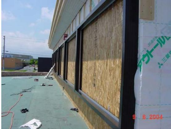
断熱材貼り付けポリスチレン板 20 ミリ
